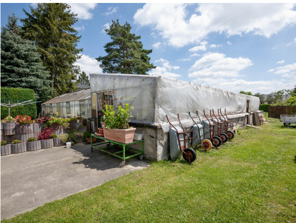
Abrissobjekt / Treibhaus - voll unterkellert
