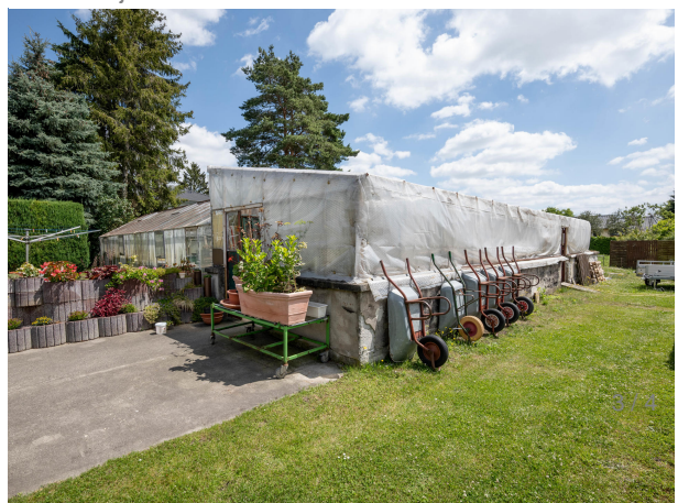
Abrissobjekt / Treibhaus - voll unterkellert
